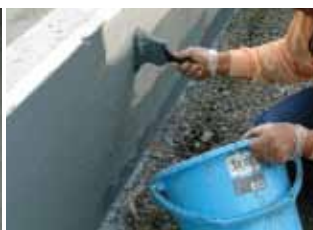
3 ターミパージ ® 施工
