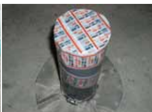
2 ターミメッシュ ® 施工(基礎埋設配管部)
