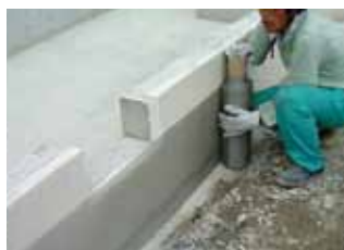
1 ターミメッシュ ® 施工(基礎外断熱部)
