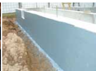
4 メッシュ防蟻施工完了
